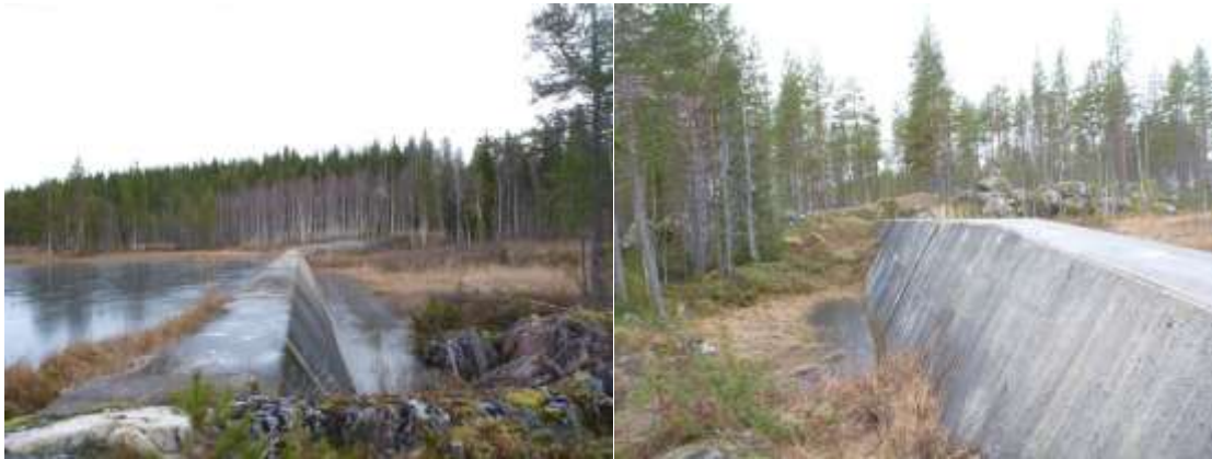
Figur 16. Grunddamm Tuggensele kraftverk (betongbarriär)
