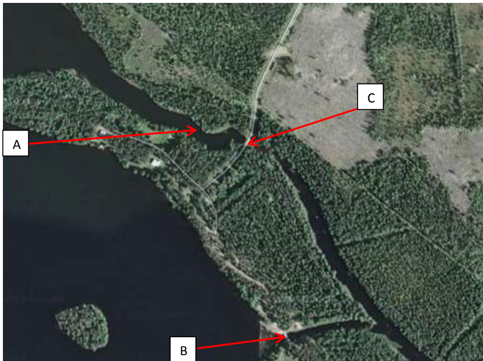
Figur 5. Damm 2. Karta över Ramsans inlopp i Sundö. A. Gamla fåran. B. Grävd kanal vid spgeldamm. C. Vägtrumma, ny bro.
