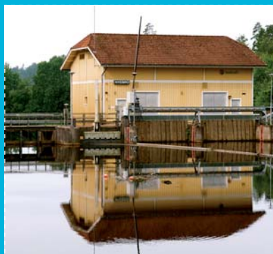
2. Ngebro BYGGÅR: 1983 AGGREGAT: Semikaplanturbiner, vertikal placering EFFEKT: 1,4 MW NORMALÅRSPRODUKTION: 7 GWh FALLHÖJD: 4,3 m
