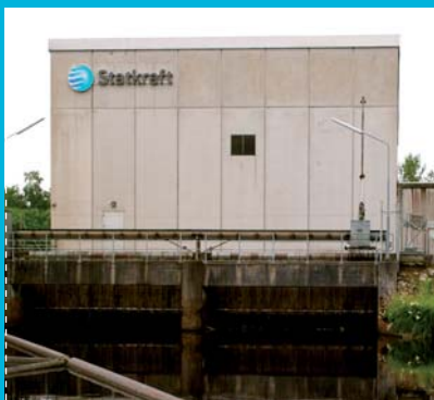
3. Fröslida BYGGÅR: 1983 AGGREGAT: Semikaplanturbiner, vertikal placering EFFEKT: 2,4 MW NORMALÅRSPRODUKTION: 12,5 GWh FALLHÖJD: 5,5 m
