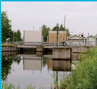
1. Hylte BYGGÅR: 1989 AGGREGAT: Kaplanturbiner, vertikal placering EFFEKT: 26 MW NORMALÅRSPRODUKTION: 100 GWh FALLHÖJD: 63 m
