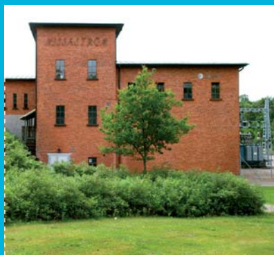
4. Nissaström BYGGÅR: 1950 AGGREGAT: Kaplanturbiner, vertikal placering EFFEKT: 11,2 MW NORMALÅRSPRODUKTION: 60 GWh FALLHÖJD: 29 m
