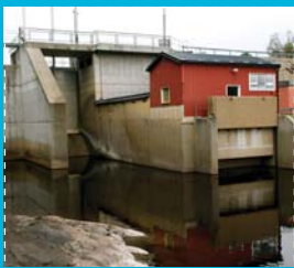
11. Nyfors BYGGÅR: 1990 AGGREGAT: Kaplanturbin EFFEKT: 1,1 MW NORMALÅRSPRODUKTION: 5 GWh FALLHÖJD: 8 m
