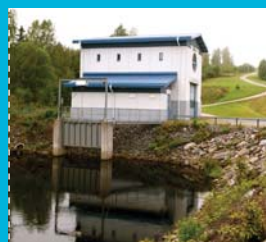
10. Brynge BYGGÅR: 1994 AGGREGAT: Kaplanturbin EFFEKT: 5 MW NORMALÅRSPRODUKTION: 19 GWh FALLHÖJD: 37 m
