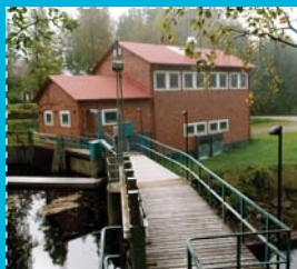
8. Sidensjö BYGGÅR: 1949 AGGREGAT: Kaplanturbin EFFEKT: 1,3 MW NORMALÅRSPRODUKTION: 4 GWh FALLHÖJD: 16 m
